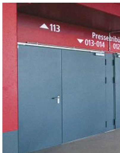
BrS-Tor EI 30 mit Servicetüre Ansteuerung
