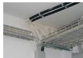
Kabelschott
