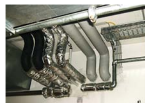
Rohrleitungsschott
